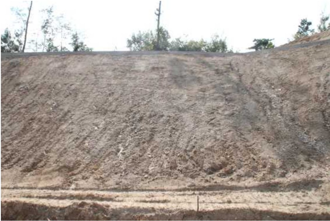
STA.0+510 상단부 녹화전
