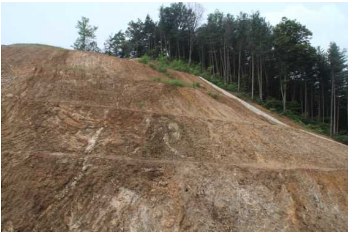
STA.0+470 상단부 녹화후
