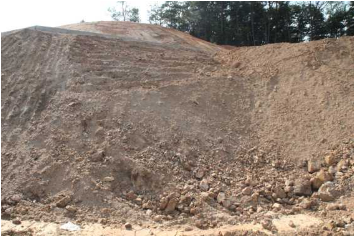
STA.0+460 상단부 녹화전
