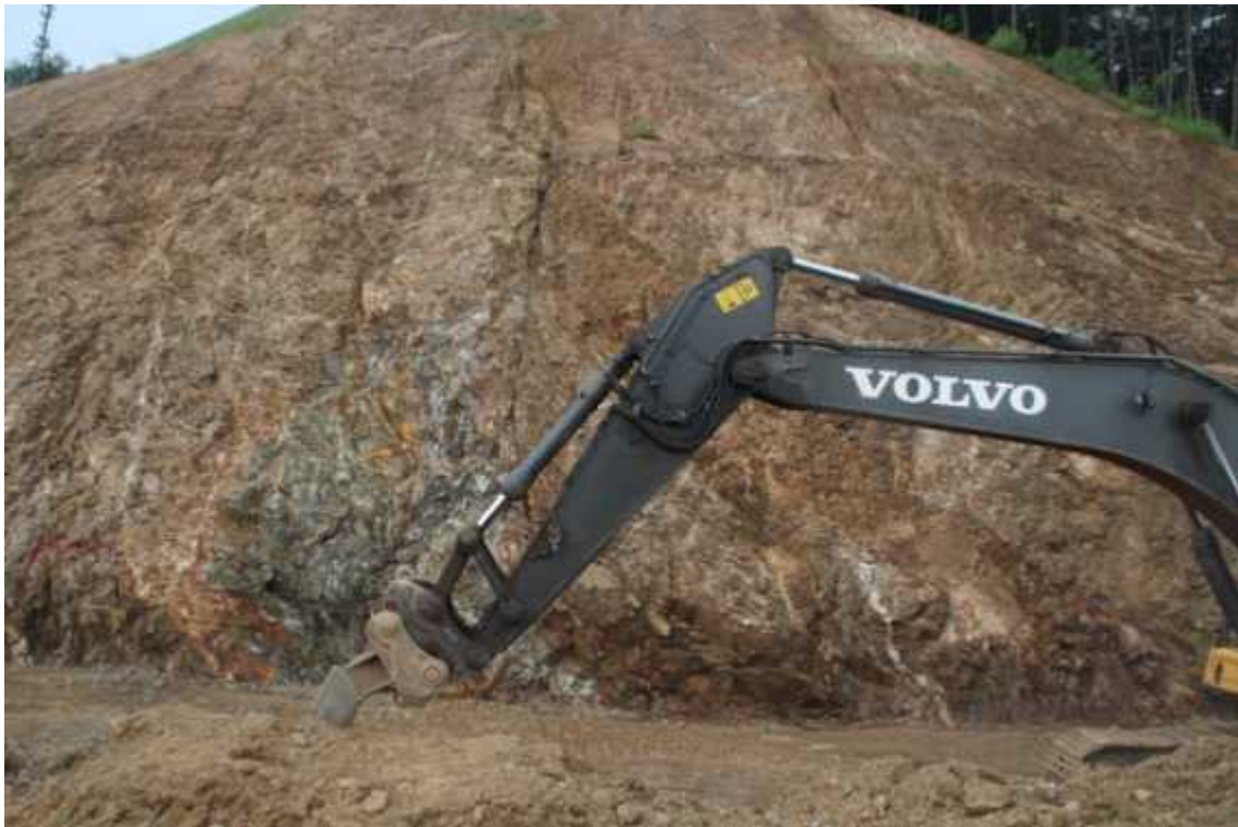
STA.0+490 하단부 녹화후
