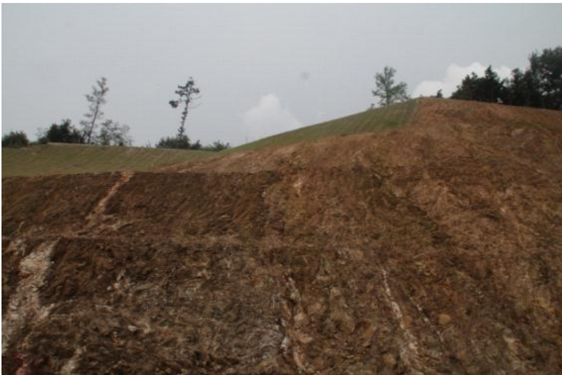
STA.0+510 상단부 녹화후
