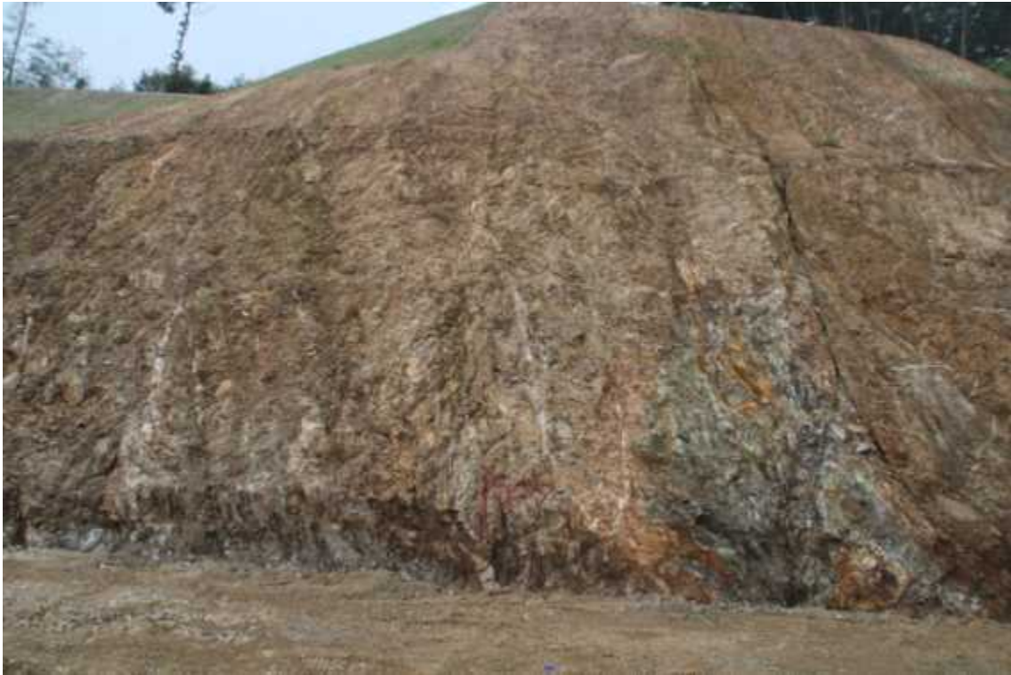
STA.0+500 하단부 녹화후
