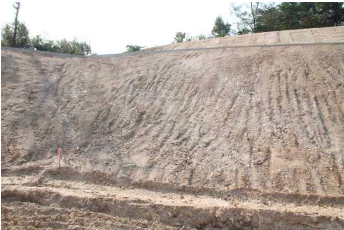
STA.0+500 상단부 녹화전
