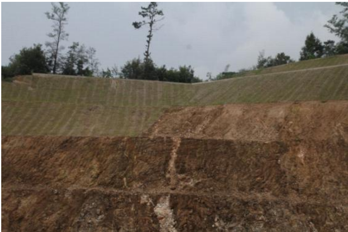
STA.0+520 상단부 녹화후
