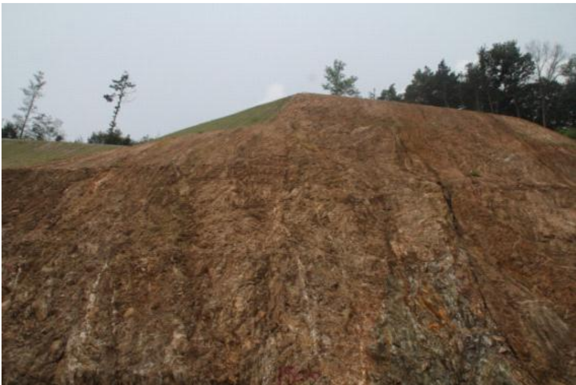
STA.0+500 상단부 녹화후
