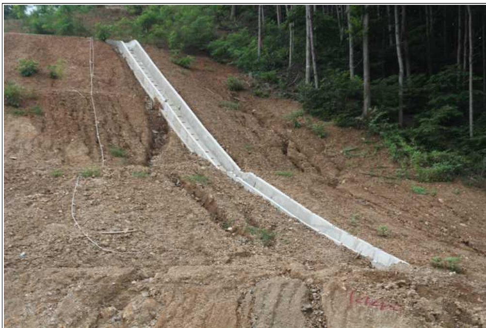
【그림 6】 산마루 배수구 설치
