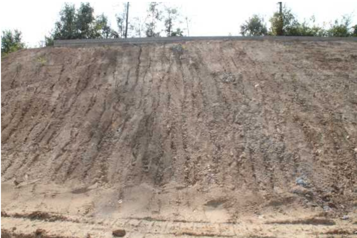
STA.0+530 상단부 녹화전
