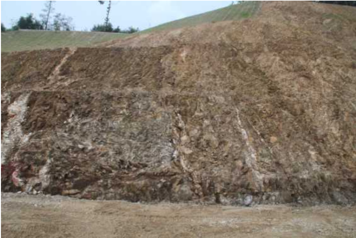
STA.0+510 하단부 녹화후
