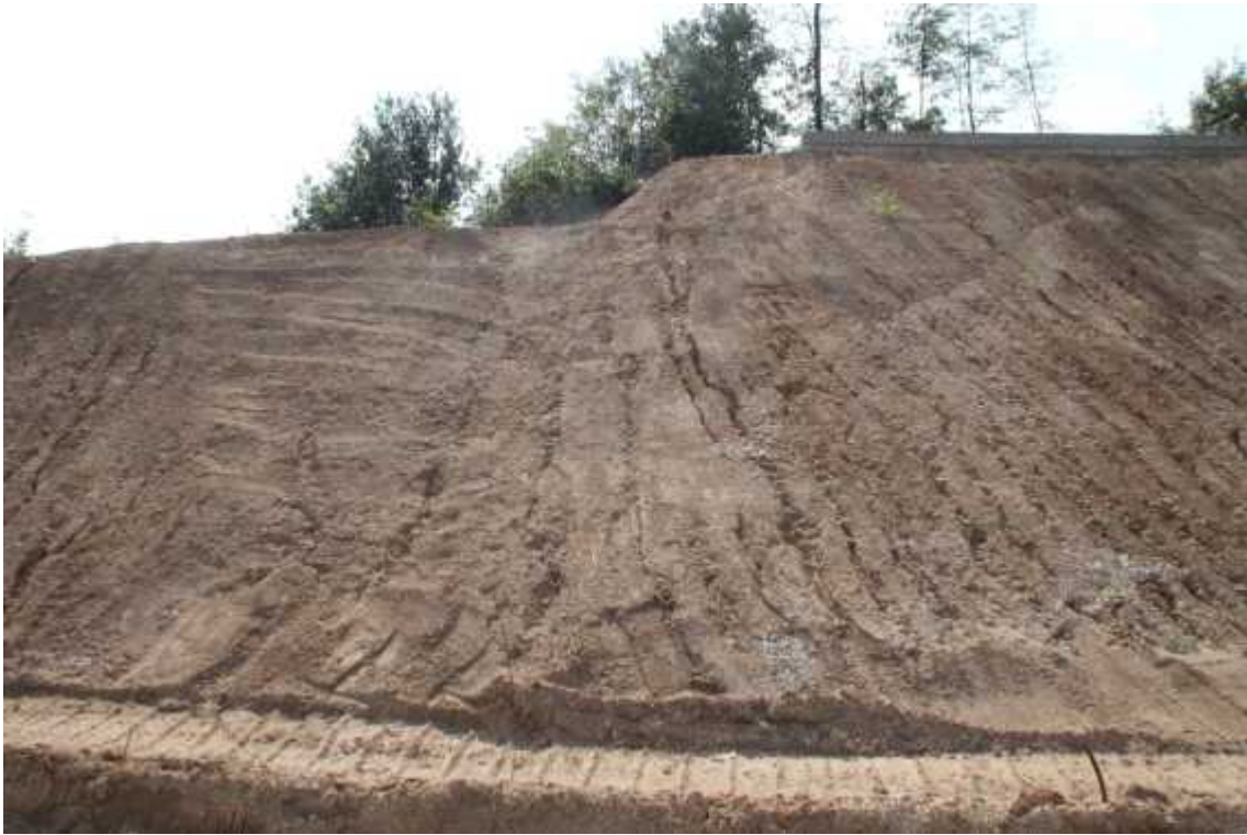
STA.0+540 상단부 녹화전
