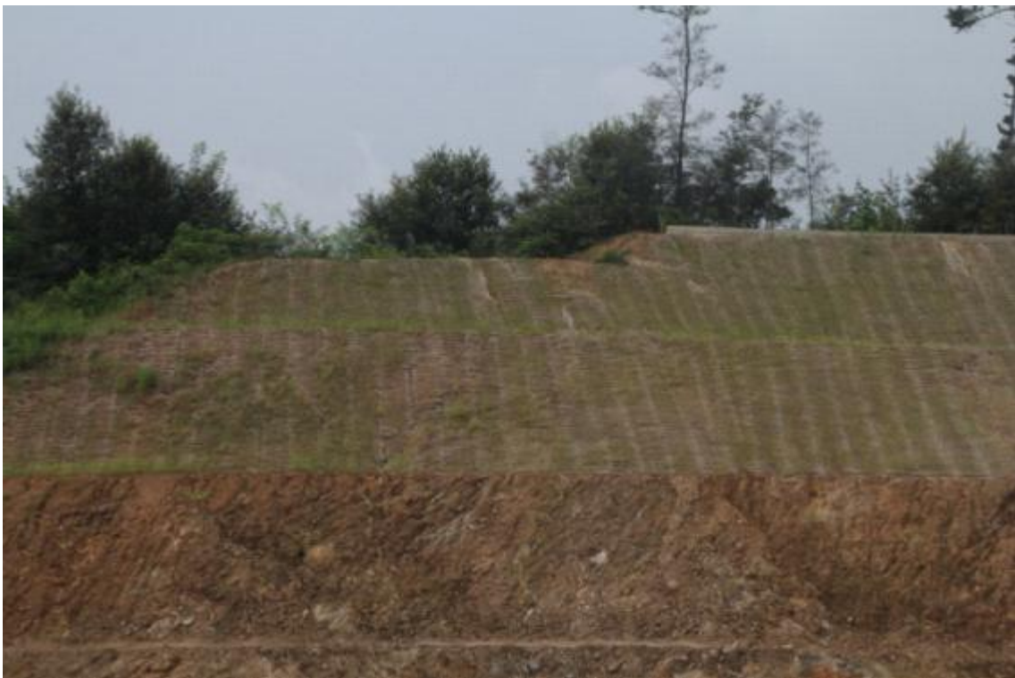
STA.0+540 상단부 녹화후
