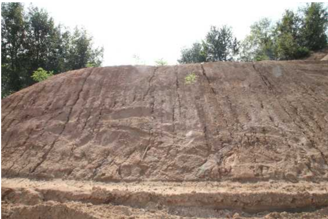
STA.0+550 상단부 녹화전
