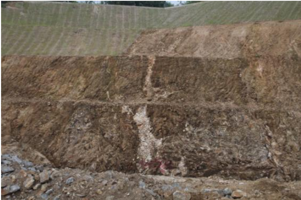
STA.0+520 하단부 녹화후
