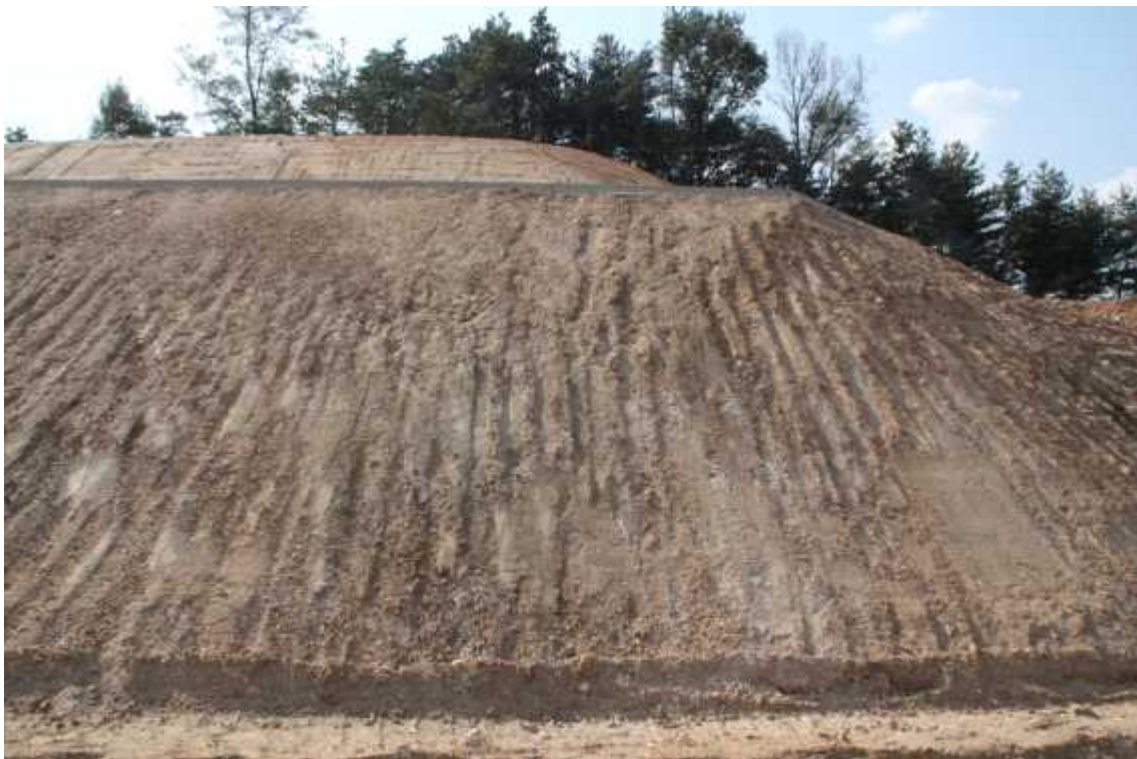
STA.0+480 상단부 녹화전
