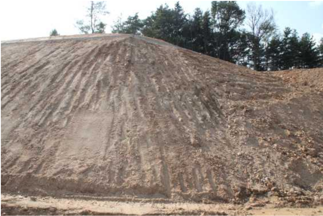
STA.0+470 상단부 녹화전
