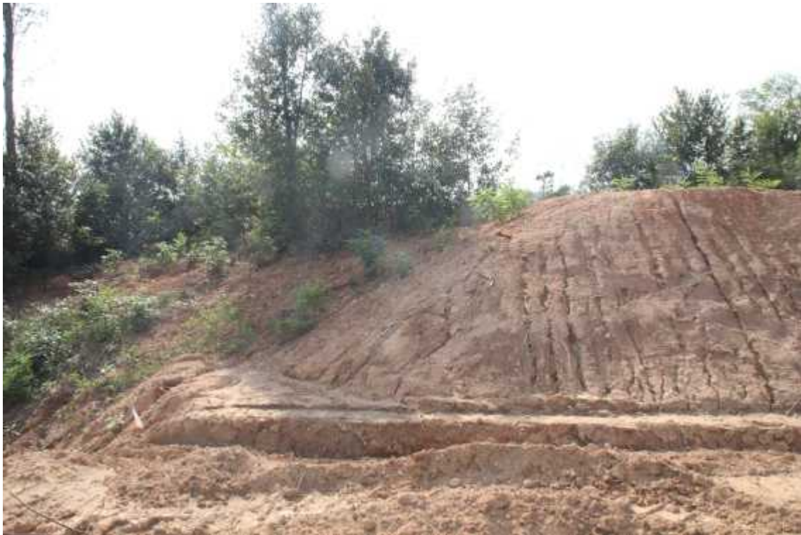
STA.0+560 상단부 녹화전
