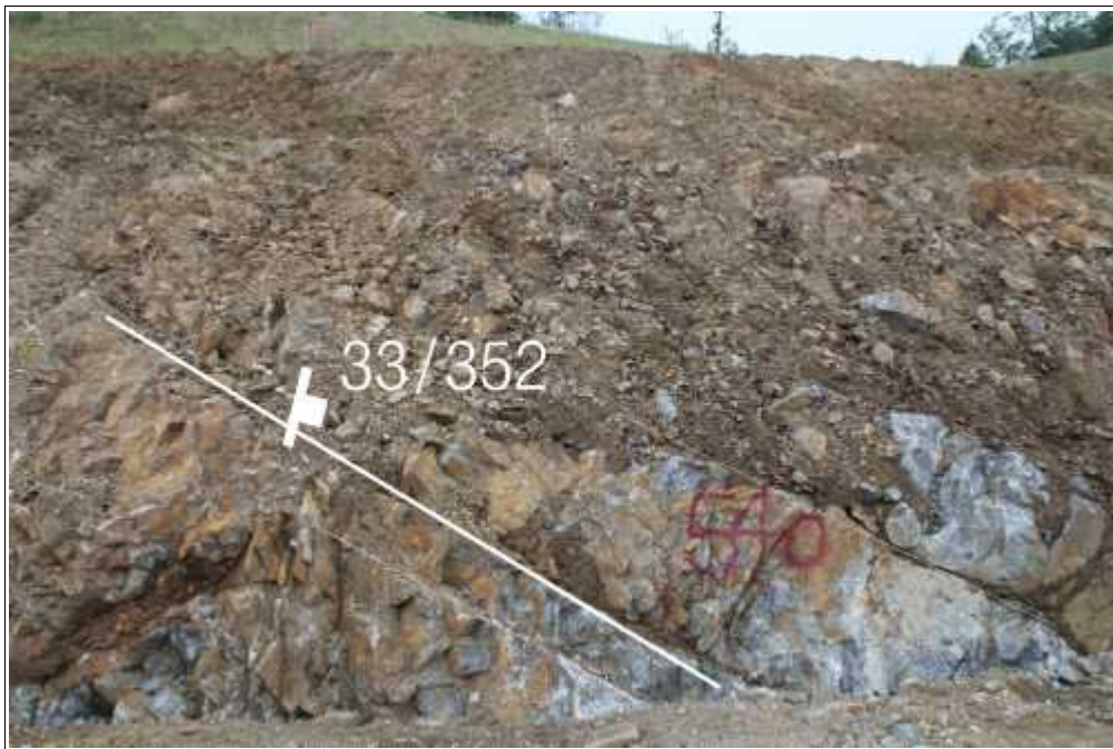
【그림 16】 B 영역에 발달한 불연속면
