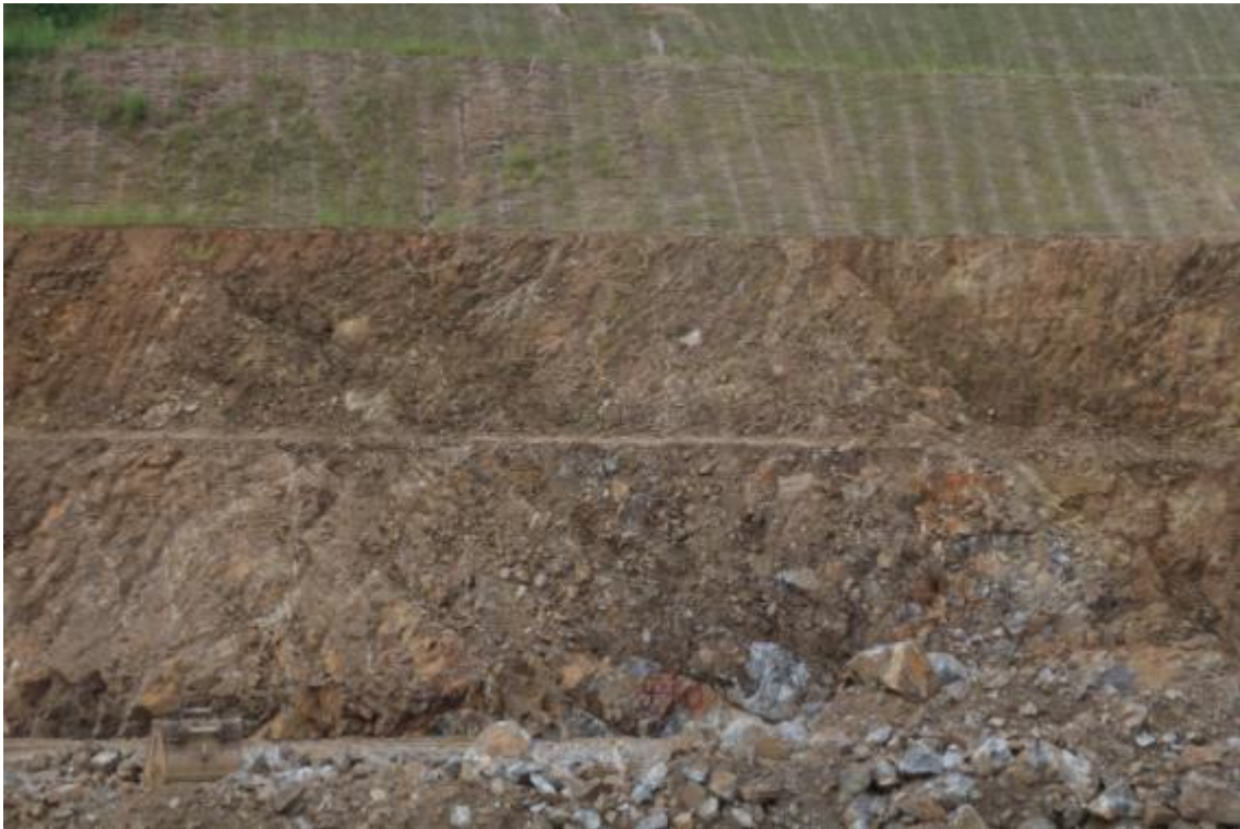
STA.0+540 하단부 녹화후
