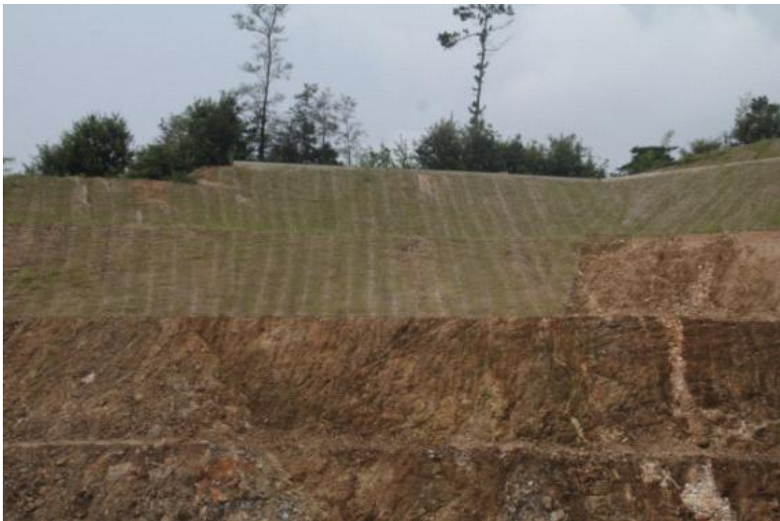
STA.0+530 상단부 녹화후
