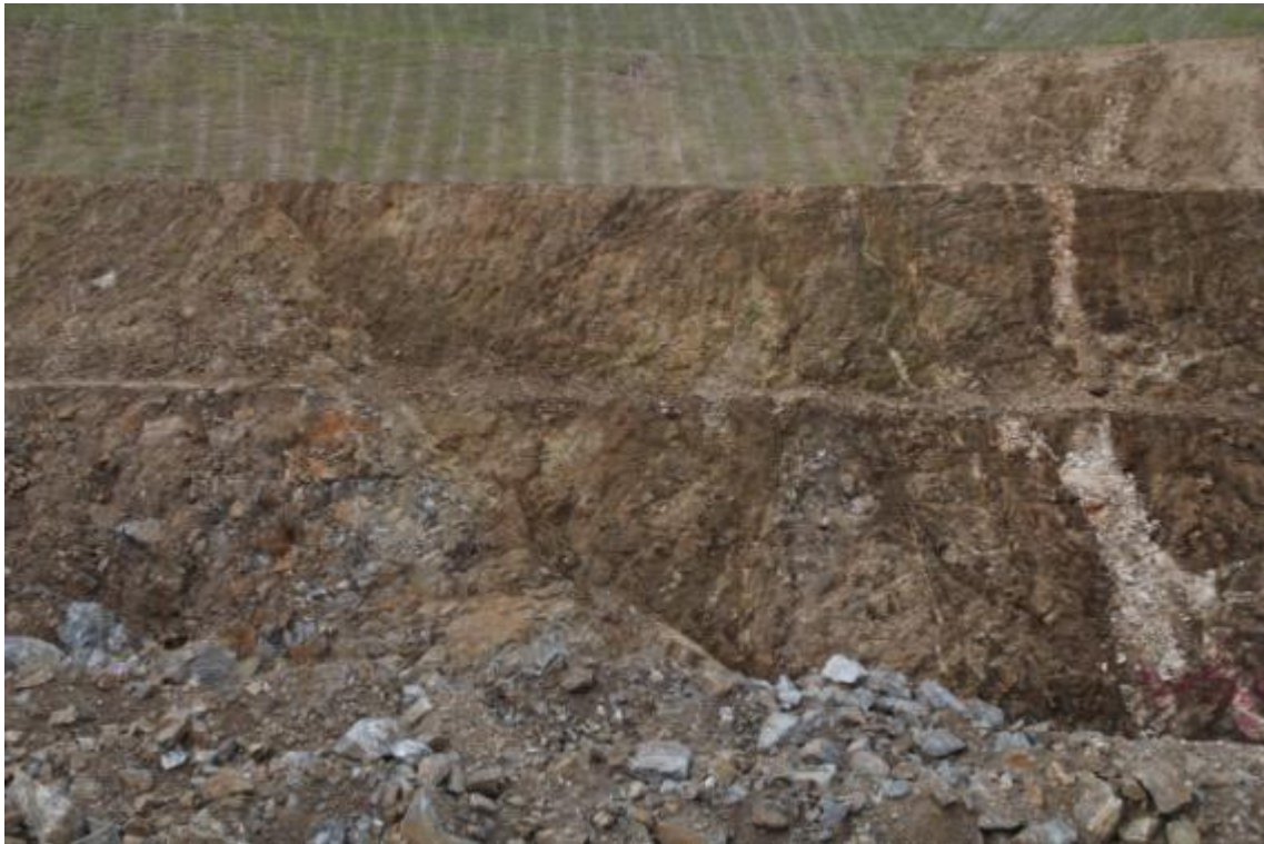
STA.0+530 하단부 녹화후
