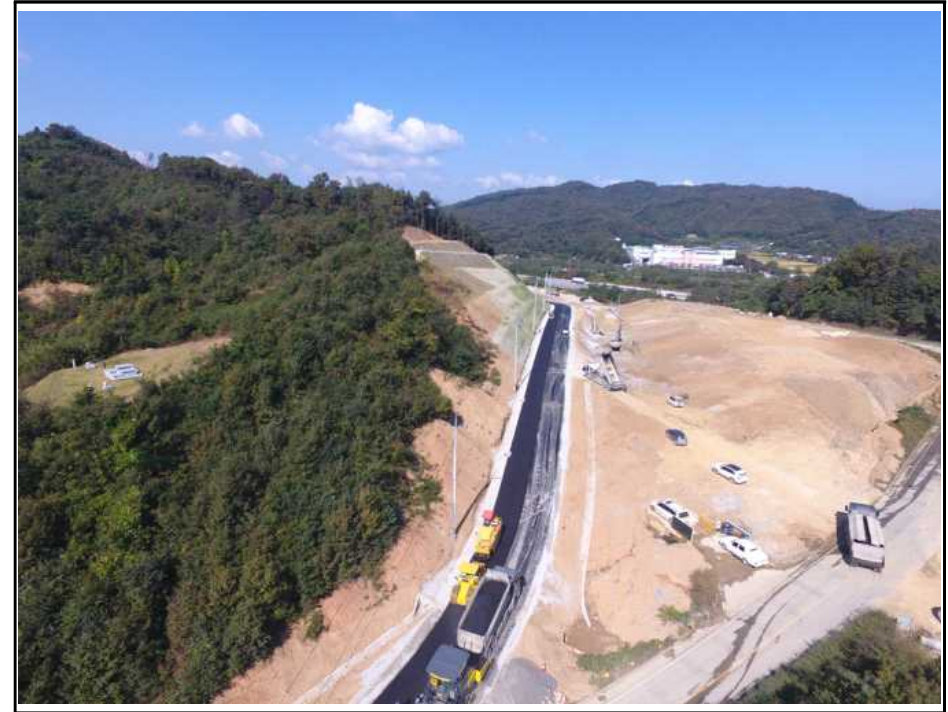
【그림 4】 깎기비탈면 종점부 측면 사진
