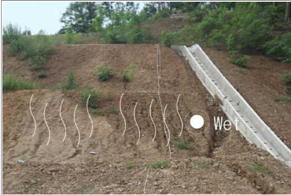
【그림 27】 D 영역 상세사진 (토사유실 및 우류침식)
