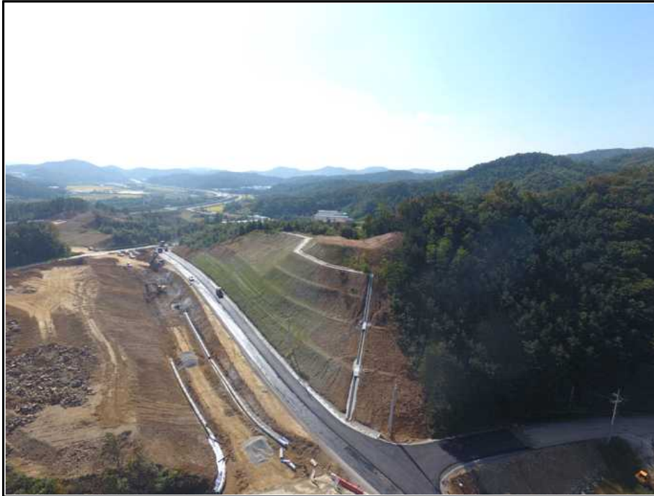
【그림 3】 깎기비탈면 시점부 측면 사진
