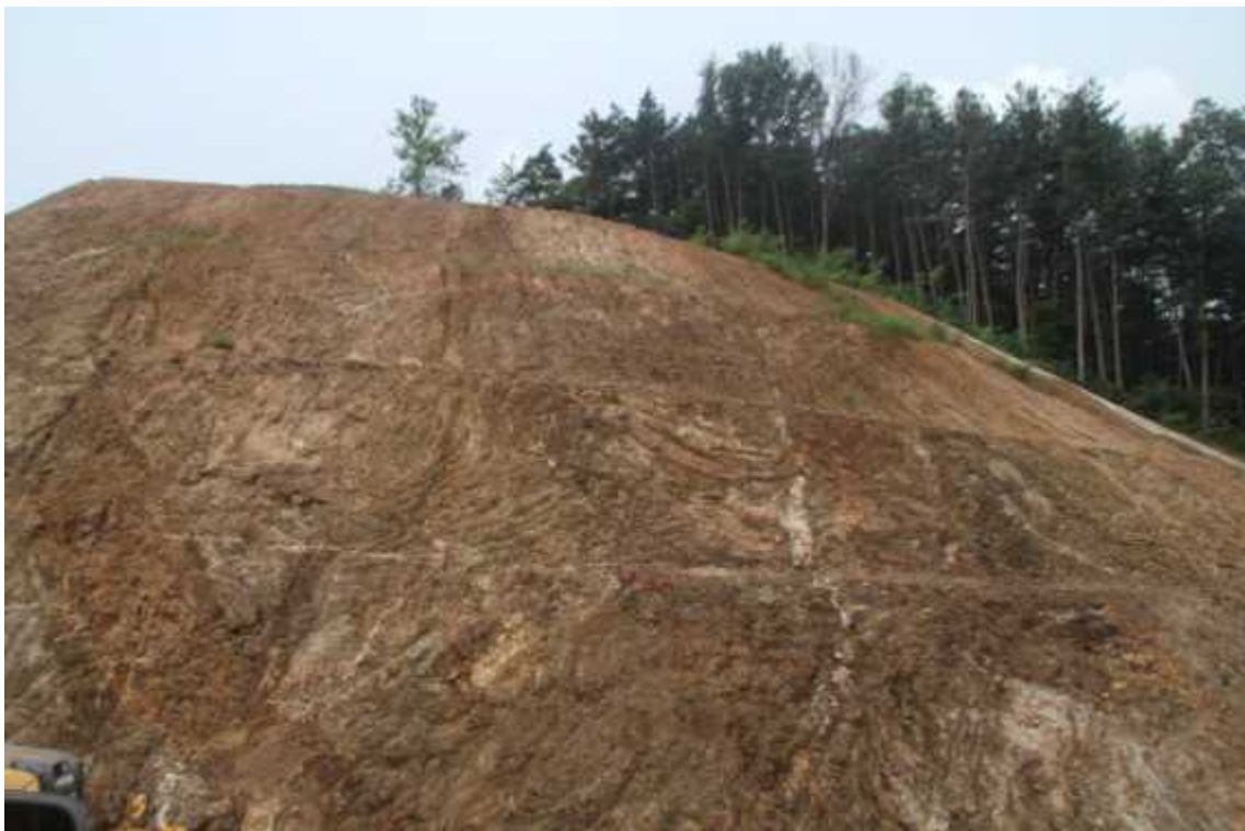
STA.0+480 상단부 녹화후
