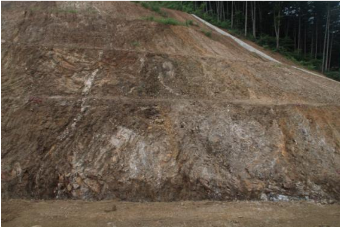
STA.0+470 하단부 녹화후
