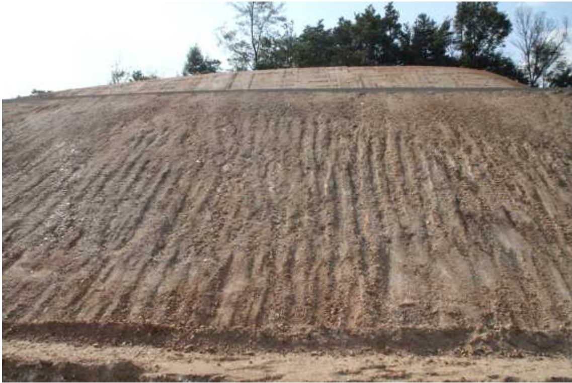
STA.0+490 상단부 녹화전
