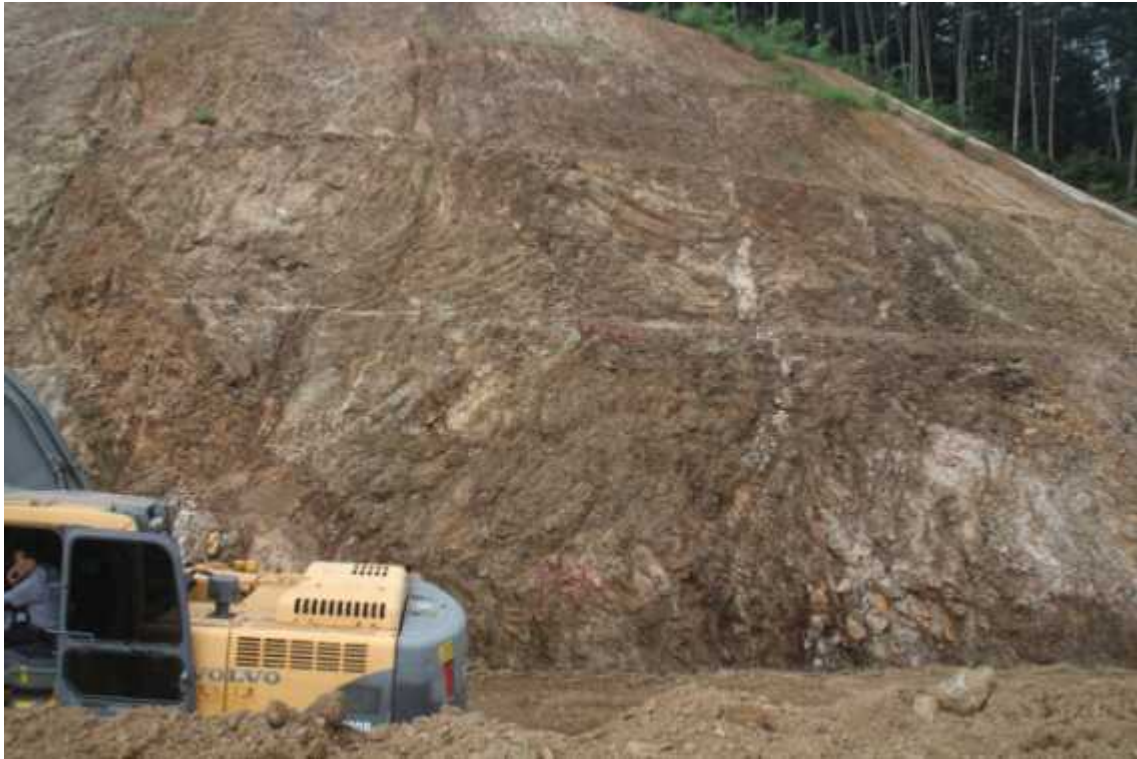
STA.0+480 하단부 녹화후
