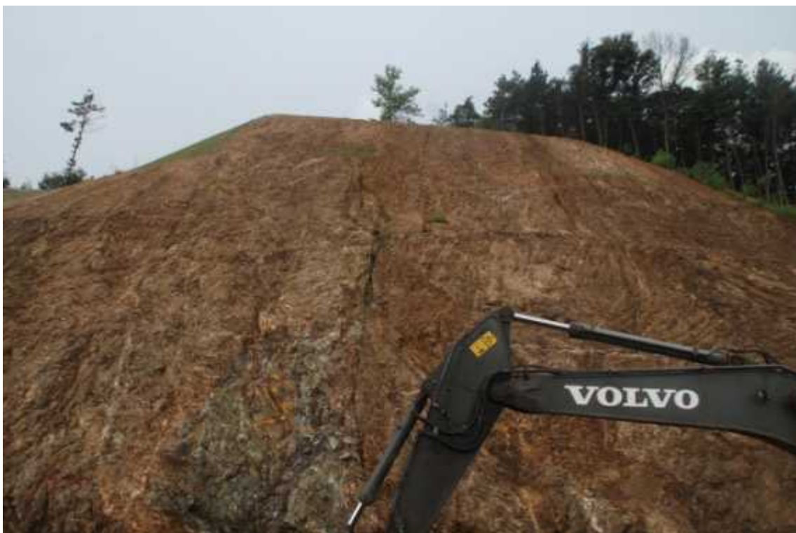
STA.0+490 하단부 녹화후
